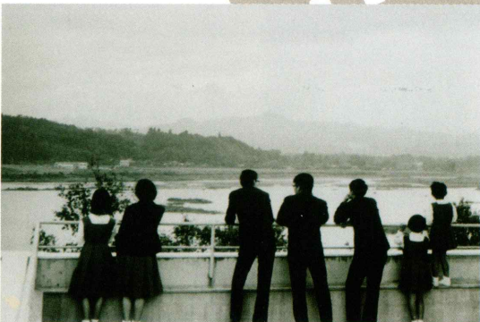
昭和40年代 生徒寮屋上より
