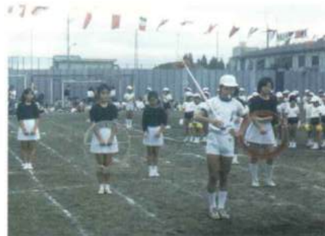
昭和62年 S校舎工事中のグラウンド
