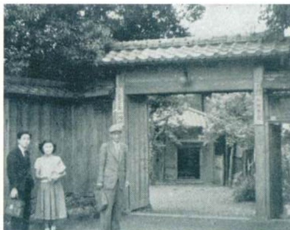
昭和30年頃 旧通用門 北泉寮大玄関前 現在は北側塀に沿って石垣のみ残る
