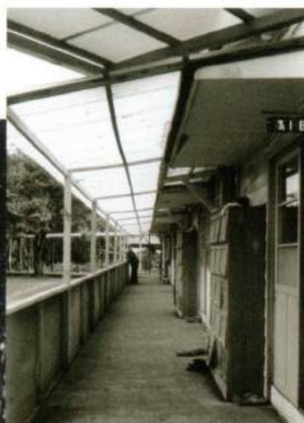
ブロック校舎廊下
